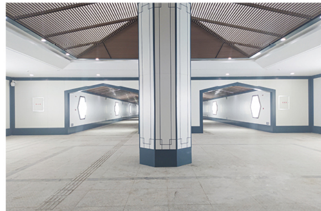
东汇公园南下穿护城河隧道工程
